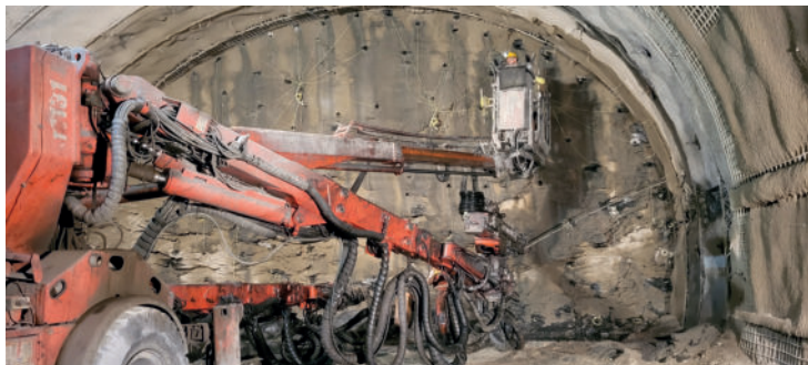
Vortriebsarbeiten im Brennertunnel
