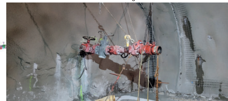
Preventer bei Hochstegenzone im Brennerbasistunnel
